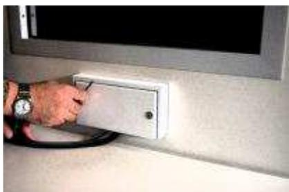
3) Una volta introdotti lasciarli cascare e richiudere posizionando il coperchio (esterno ed interno) precedentemente tolto e serrare. Le viti a brugola con la chiave in dotazione.
