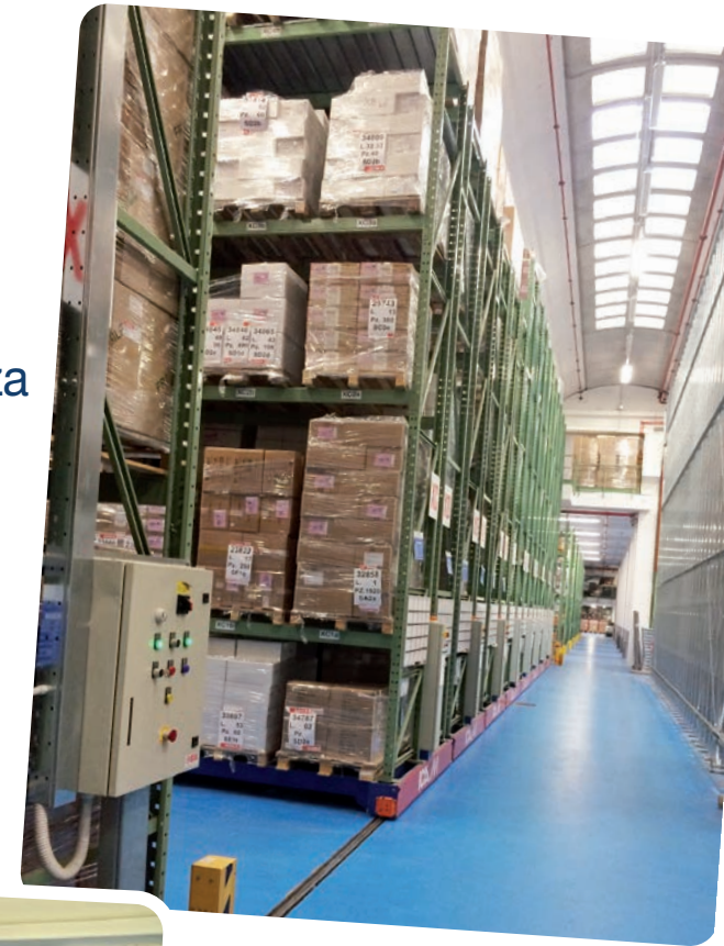
Magazzino su rotaia
